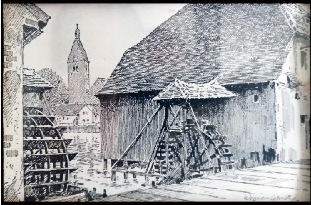
**Bild 10** deutlich erkennbar die beiden "Zieherker" mit den vom Rischemüller beanstandeten "panzerrädern" (eigentlich "Pansterräder"), d. h. dem jeweiligen Wasserstand anpassbare Tauchtiefe der Räder und Radschaufeln zur Verbesserung des Wirkungsgrades (Blickrichtung vom Ufer der „Geisel“ zur Neumarktkirche)
